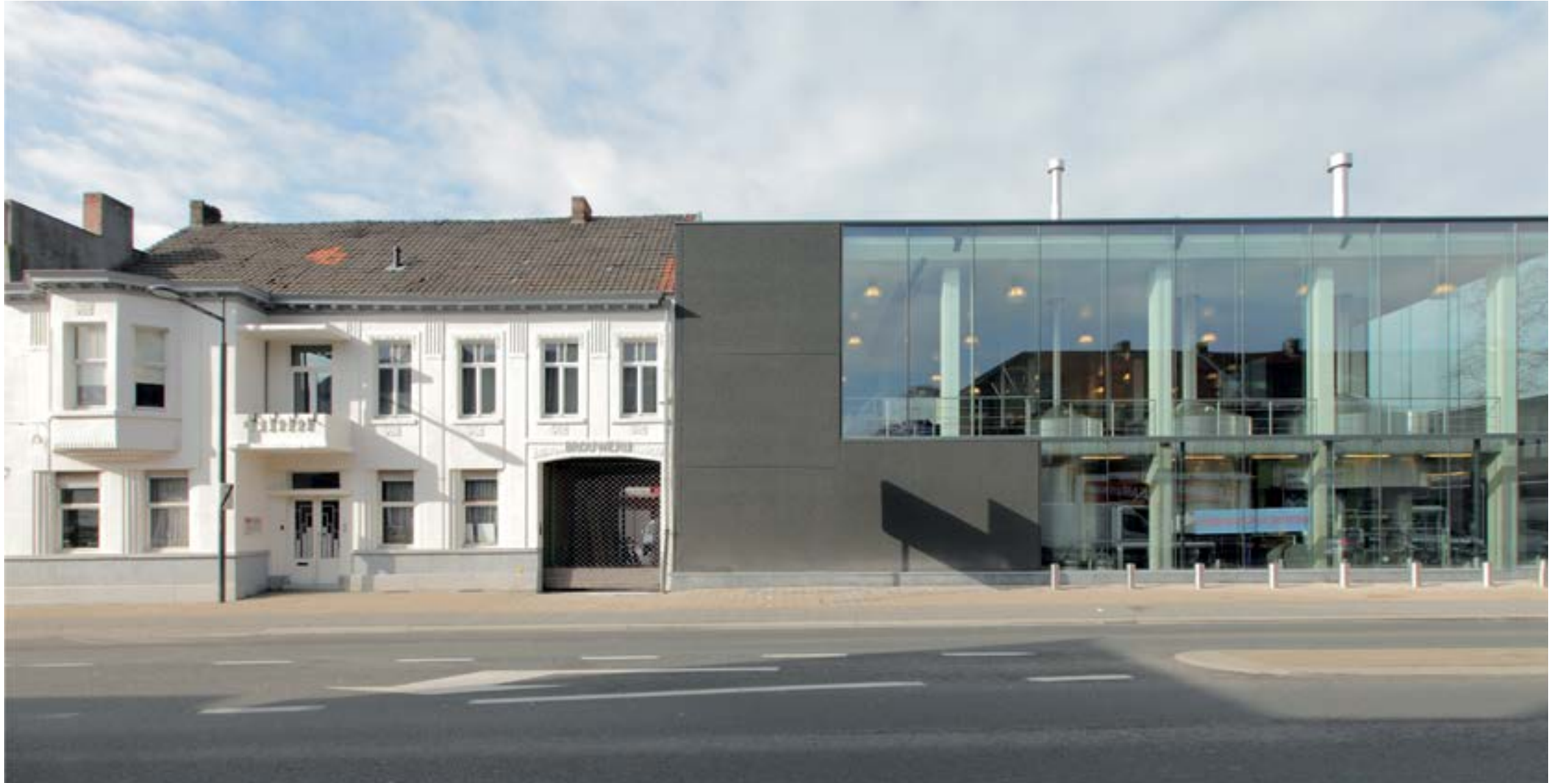
13. Nieuwe brouwerij gebouwd naast historisch pand brouwerij (bouwkundig relict)
